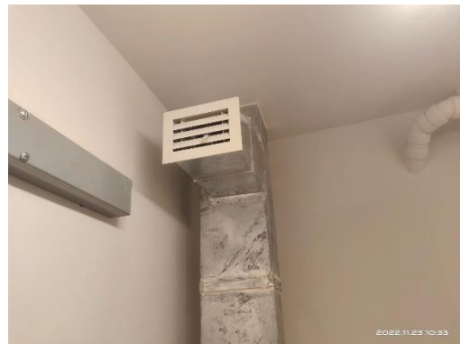
รูปที่ 11 เครื่องดูดกลิ่นห้องพักขยะ
