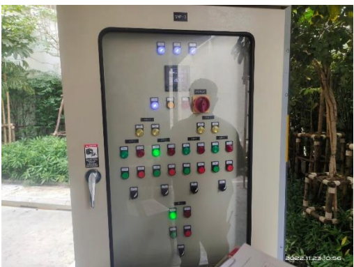
รูปที่ 29 ตู้ควบคุมระบบบำบัดน้ำเสียและมิเตอร์น้ำเสีย
